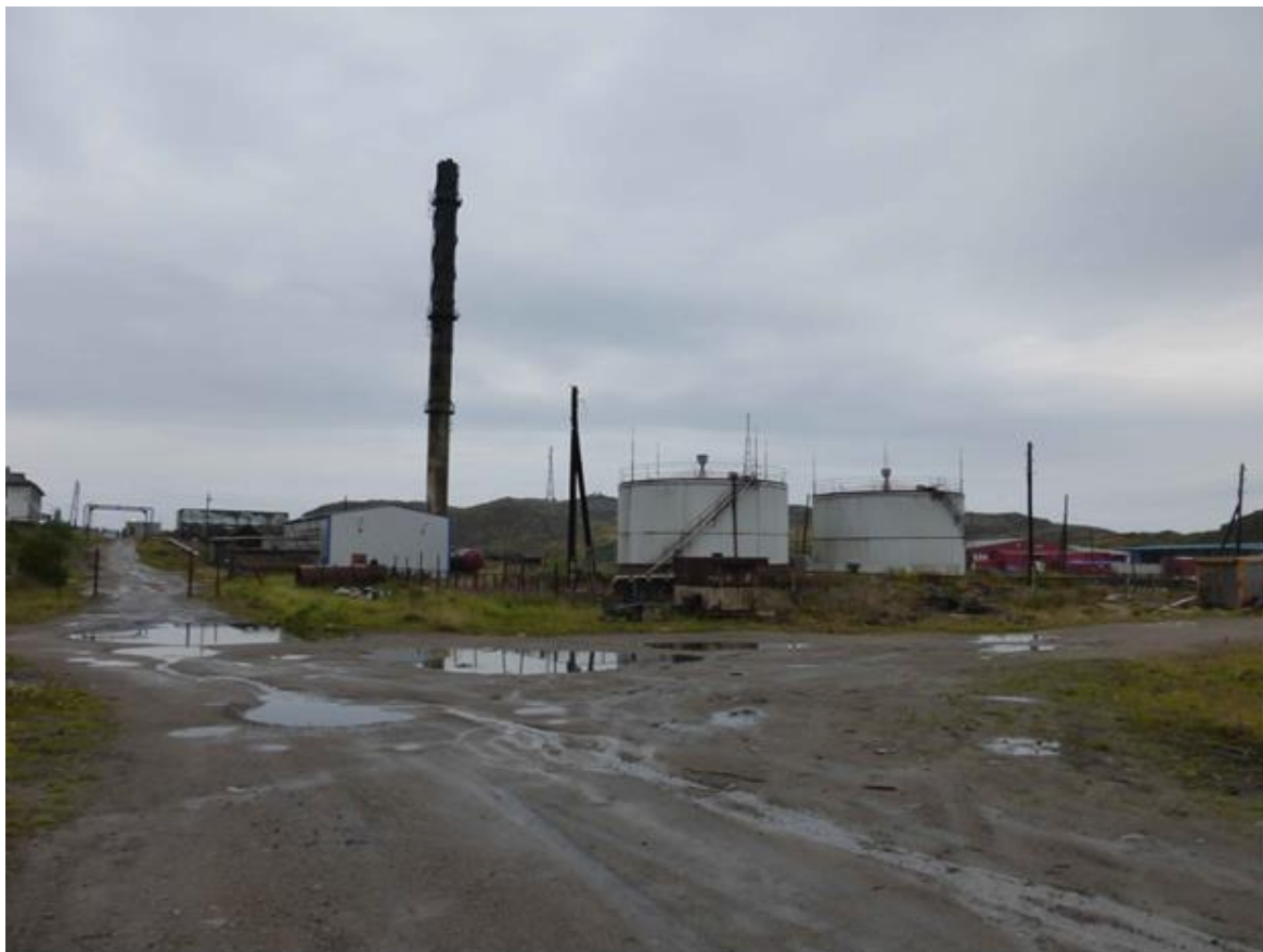
Рисунок 2.1.1.1 – Внешний вид мазутной котельной
