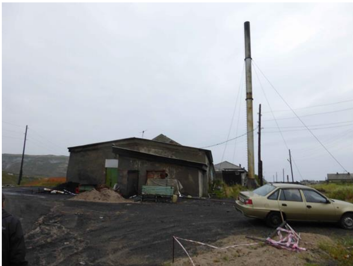
Рисунок 2.1.1.2 – Внешний вид угольной котельной
