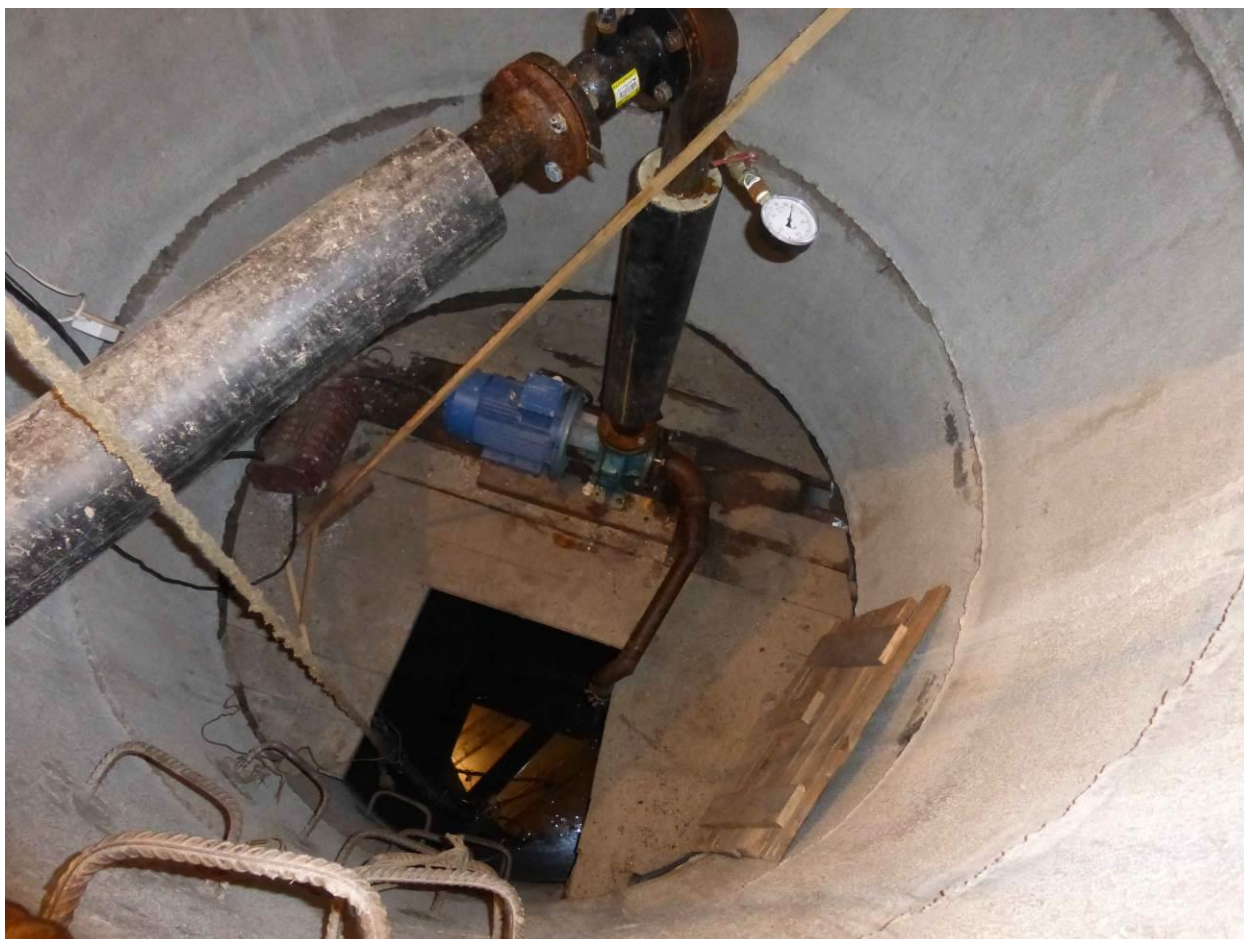
Рисунок 2.2.1.4 – Водозаборный колодец с. Териберка вид сверху (правый берег)
